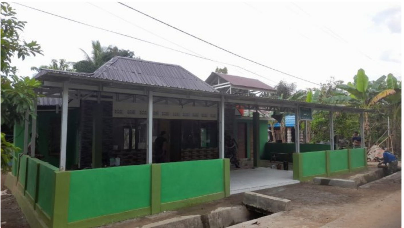
TMMD ke-116 Kodim HST Rampungkan Rehab Darul Khair
