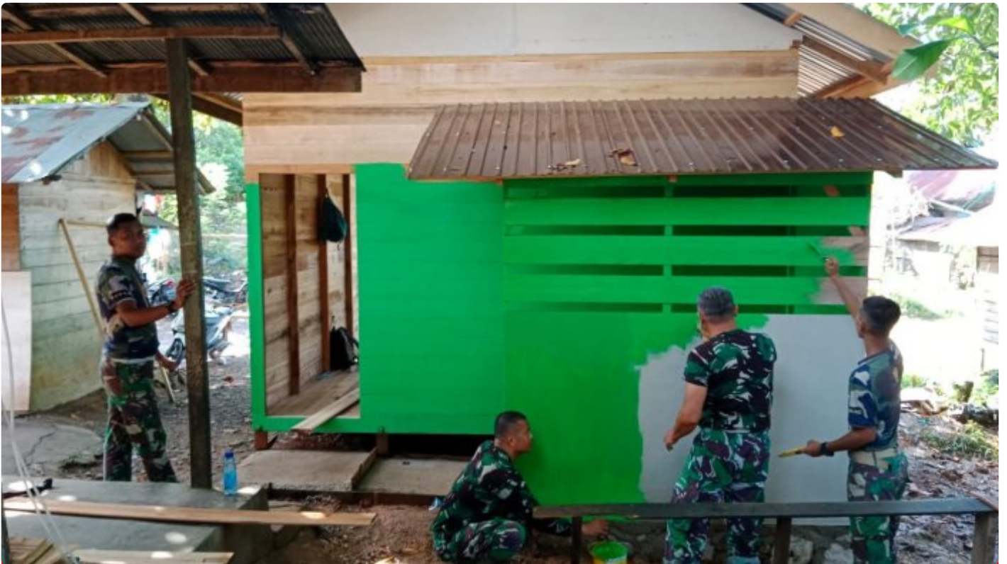
Rehab RTLH TMMMD ke-116 Kodim 1002/HST Masuk Tahap Pengecetan
