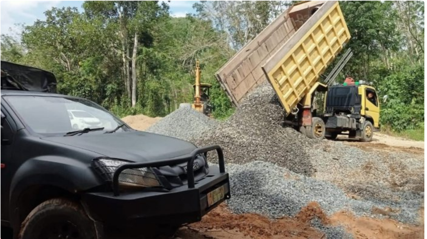
Pra TMMD ke-116 Tahun 2023 Kodim 1002/HST, Material Terus Didatangkan Ke Lokasi
