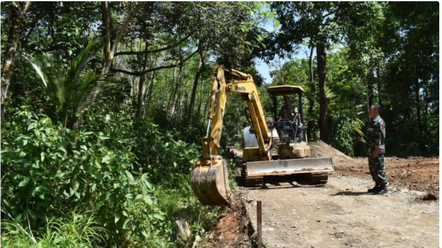
Jalan Sasaran TMMD ke-116 Kodim 1002/HST Dibantu ALat Berat Buka Jalan
