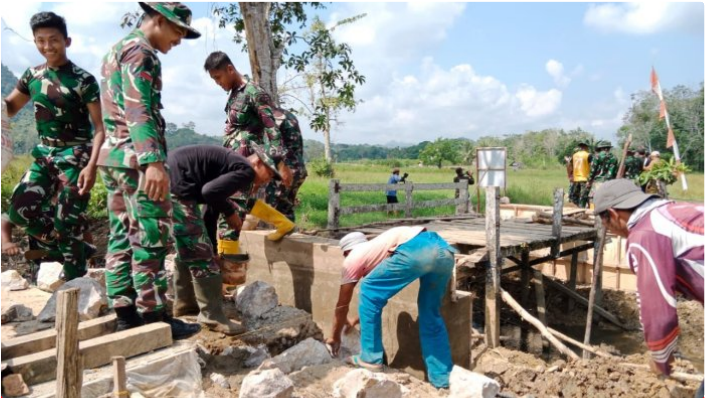
Capai 30 persen, Pengerjaan Rebah Jembatan Terus Digenjot
