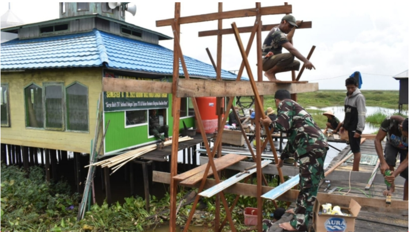
Anggota Kodim 1002/HST Sedang Membangun Tempat Penampungan Air Bersih Di Dusun Awang Landas
